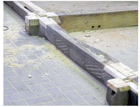
(8) Wiederherstellung der kraftschlüssigen Verbindungen des Stichgebälks (Ostseite, oberes Stockwerk)
