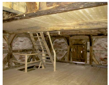
(10) Oberes Stockwerk nach Fertigstellung
