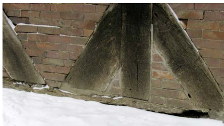
(3) Die Eichenschwelle ist durch ständigen Feuchtigkeitskontakt vollständig verrottet.
